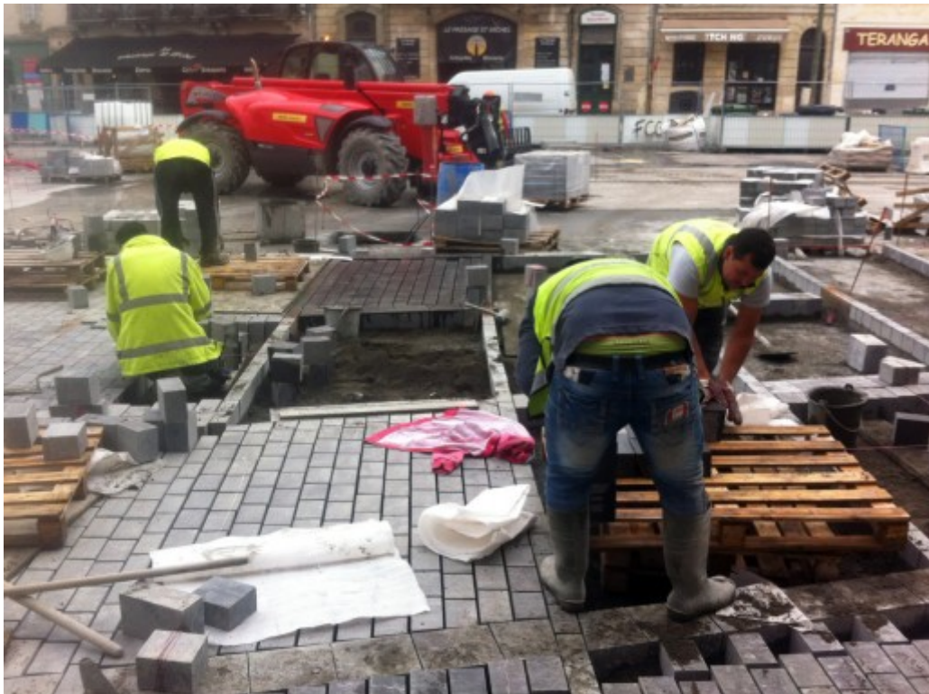
La place Saint-Michel en travaux, mars 2014 (WS/Rue89 Bordeaux)
